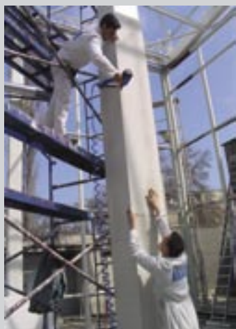
Облицоване на метална колона с Vidiwall
